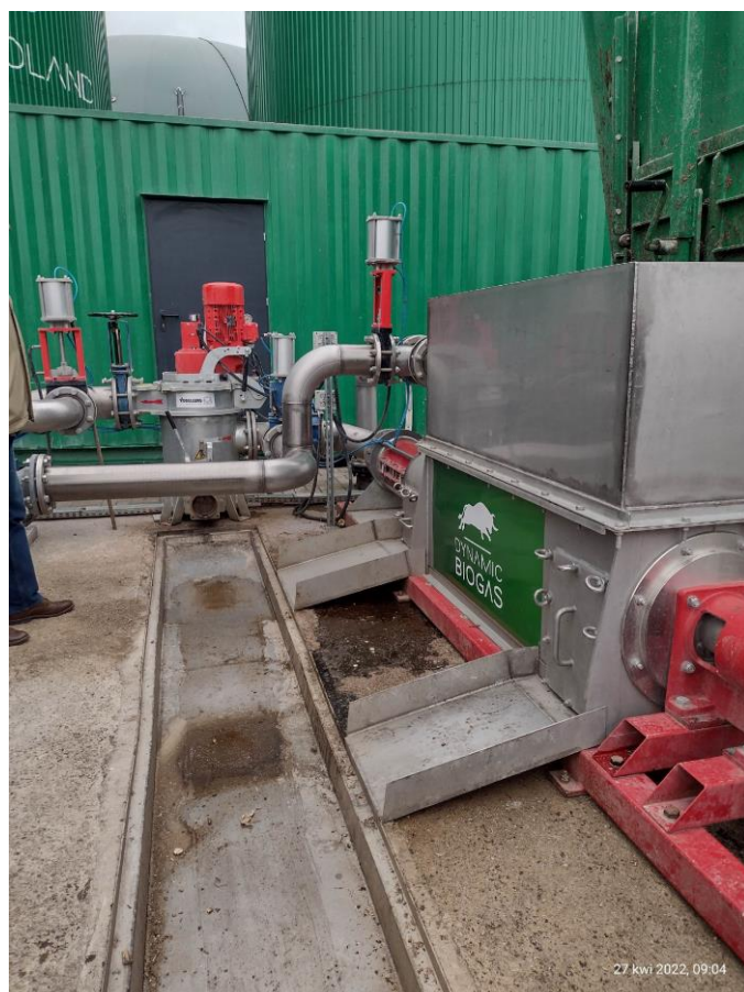
Instalacja a pomocą, której wpompowywane są odpady.
